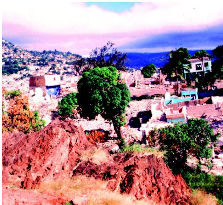
Figura 5: Parte de la colonia el Soto, destruida por el deslizamiento. Observe la rotación con cabeceo hacia atrás indicado por el árbol.
