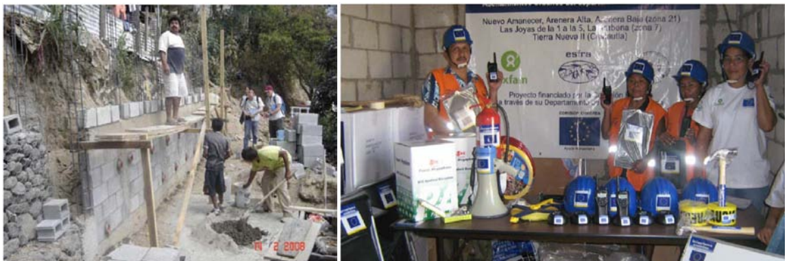
Hình: Sự trợ giúp nhằm giảm nhẹ rủi ro do trượt lở đất gây ra dựa trên cộng đồng tại RiskCity. Bên trái: các tường chắn đơn giản được xây dựng bởi người dân địa phương với các vật liệu xây dựng cung cấp bởi NGO. Bên phải: các trang thiết bị được NGO tặng cho việc đánh giá rủi ro tại biển: dụng cụ đo mưa, thiết bị liên lạc v.v
